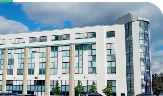
Bestandsgebäude in Dresden
